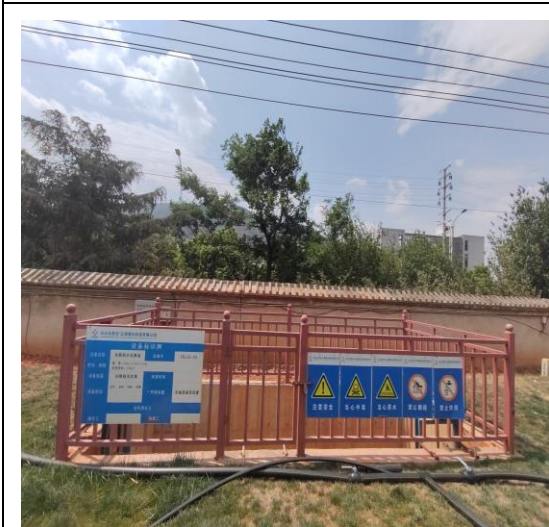
初期雨水收集池
