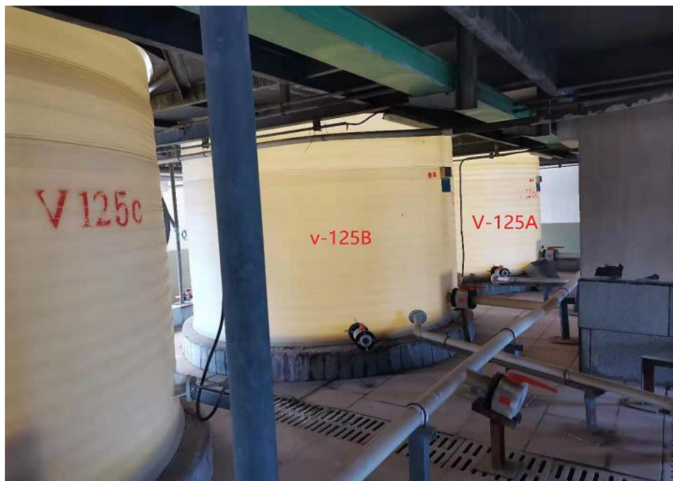
图 3.4.2 低砷聚磷酸储罐安装区现场图
