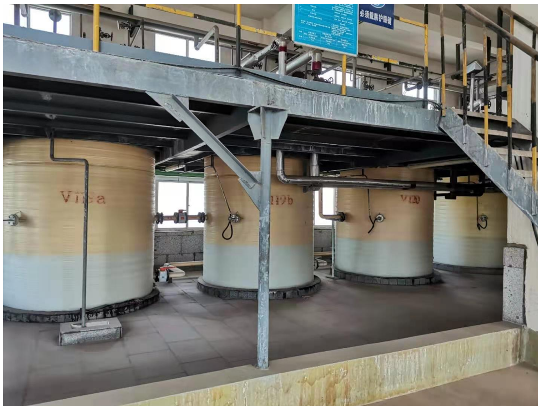
图 3.4.4 脱砷反应釜安装区现场图
