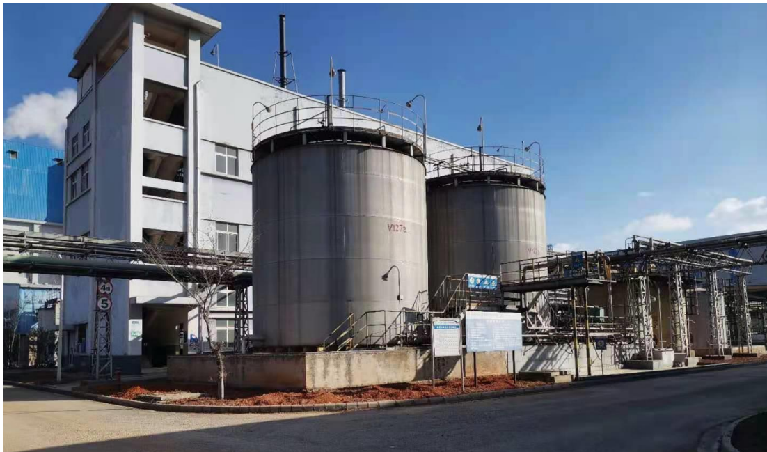
图 3.4.1 磷酸储罐区现场图
