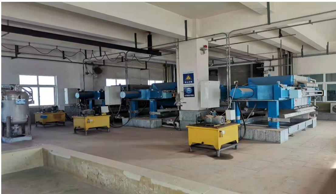
图 3.4.5 脱砷过滤机安装区现场图
