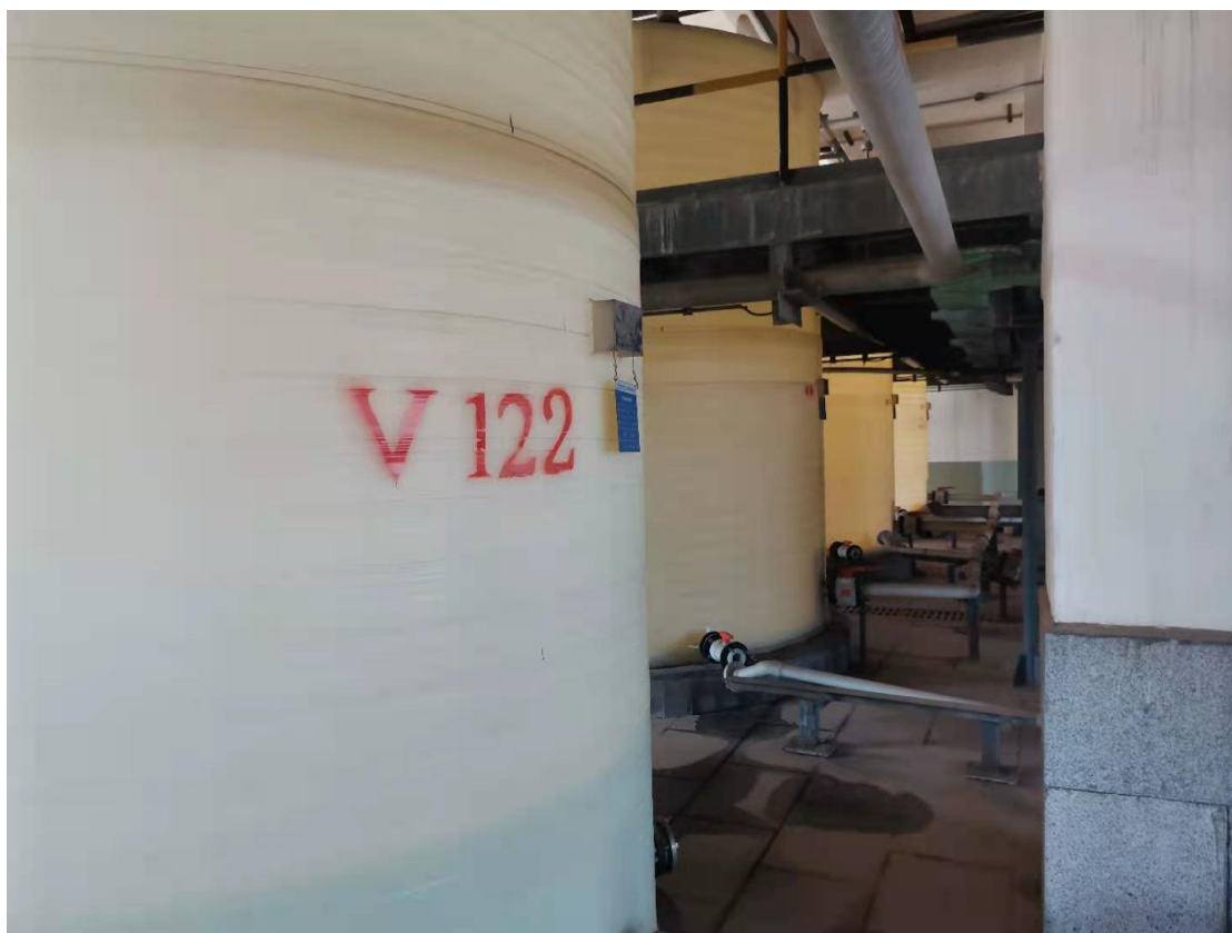
图 3.4.4 中间槽安装区现场图
