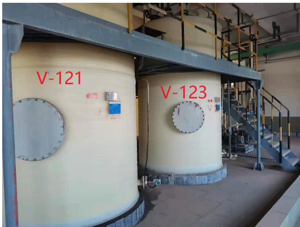
图 3.4.3 曝气槽安装区现场图
